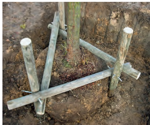
Abbildung 4: Einbau einer Wurzelballenstützung
