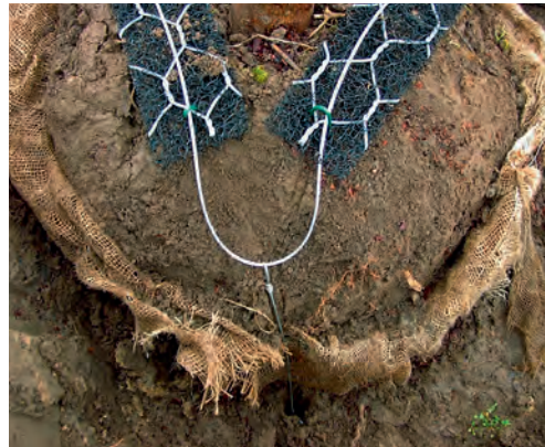
Abbildung 2: Einbau der Variante RF1 mit PLATI-MAT PM1
