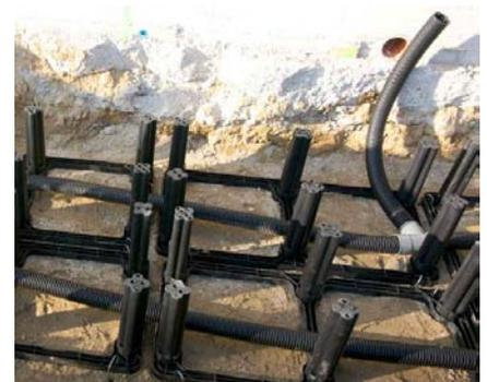
Bewässerung und Belüftung können durch die Rahmen hindurch installiert werden.
