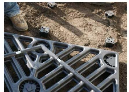
Auf die obersten Rahmen werden die Deckel montiert und verschraubt.
