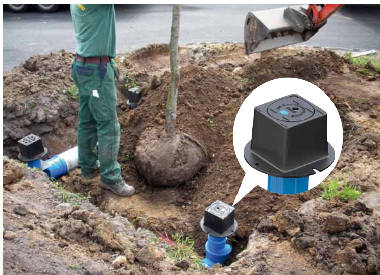
Geschlossener Deckel mit Beschriftung und farblicher Markierung (blau = Regenwasser)
