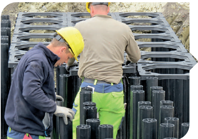
Une fois les cadres disposés comme indiqué sur le schéma, les poteaux et les cadres supérieurs sont placés. Les poteaux sont disponibles dans toutes les hauteurs. Cette hauteur peut même être ajustée durant les travaux et ce, pour pallier toute circonstance inattendue.
