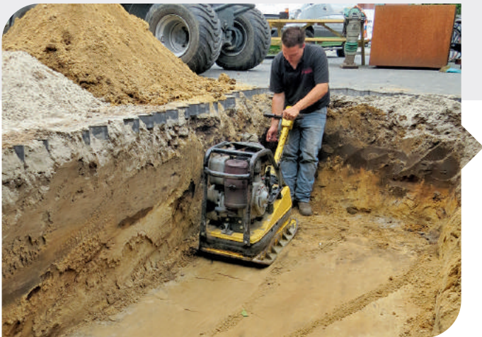
L'excavation et la préparation du substrat sont importantes ; dans de nombreux cas, il s'agit de l'activité qui prend le plus de temps.
