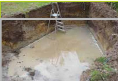
...si incontrano delle condizioni di terreno bagnato? Se il sottosuolo è troppo bagnato è necessario effettuare il drenaggio del pozzo.
