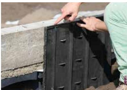
La parte inferiore dovrebbe essere almeno 5 cm più profonda della superficie del terreno all'interno del sistema.
