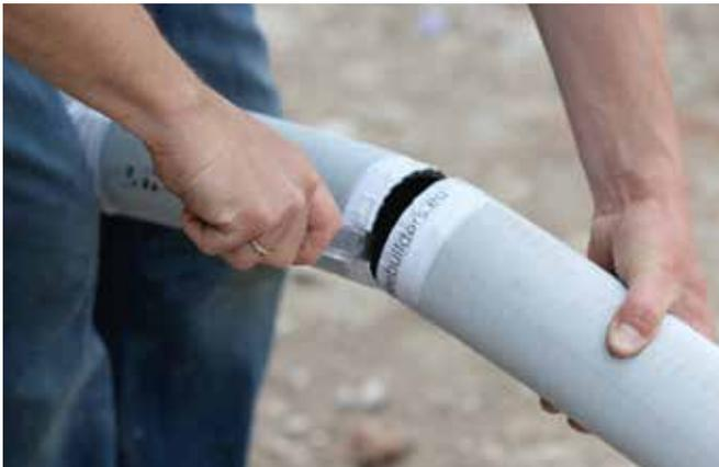
Tagliare il tubo a metà con un coltello affilato, da farlo al centro del nastro, per evitare che la calza di nylon si stacchi da entrambi i lati.
