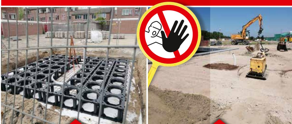
Questo sistema di pavimentazione sospesa supporta la sua intera capacità di carico solo dopo l'applicazione della pavimentazione finale. **Per evitare situazioni di pericolo, non entrare in quest'area senza pavimentazione o asfalto.**
