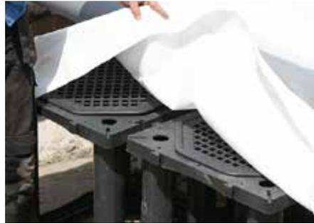
Se il dislivello è inferiore a 20 cm è possibile utilizzare il geotessile standard TP sopra il sistema.
