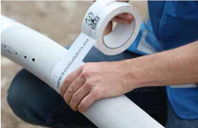
Sartoria del tubo perforato. Misurare la giusta lunghezza. Attaccare il nastro adesivo su questo punto, stretto attorno al tubo. A seconda del nastro, avvolgere il tubo 2 volte di più.
