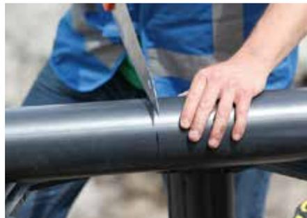
I montanti TP possono essere tagliati con un utensile manuale o una macchina sopra il sistema.
