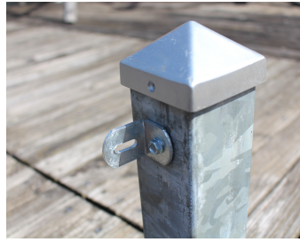
Montage mit speziellen Winkelprofilen und Spezial-Schrauben
