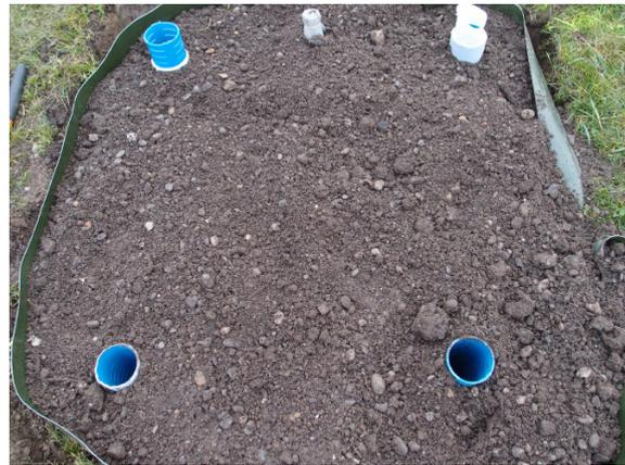
links: Sternbelüftung (TMH Hagenbucher AG), oben: einfache Tiefenbelüftung (Hortima AG) mit Grundmischung
